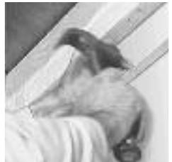
Avec un marteau et des clous, fixez le côté court du profilé mural sur les murs tout autour de la pièce. Ajustez le haut du profilé mural au ras de la ligne déjà tracée. Dans les angles, les joints du profilé mural peuvent être en onglet (A) ou en chevauchement (B).
