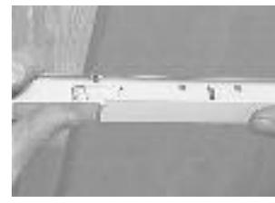
Si plusieurs longueurs de tés principaux sont nécessaires pour parcourir la pièce, vous pouvez les raccorder facilement l'un dans l'autre. Le joint de raccordement doit être à une distance maximale de 6 po d'une attache, sinon, installez une attache avec un fil métallique.
